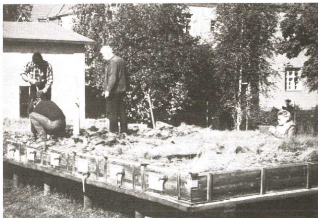
Abb. 1: Berlin-Dahlem — Modelleinrichtung zur Dachbegrünung bei abschließenden Untersuchungen am 5. 10. 1988
